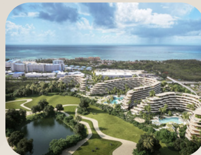
WAVE GARDEN CONSTRUCCIÓN
