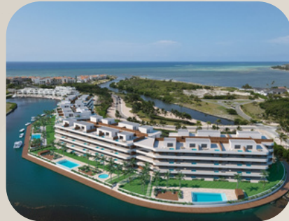
MARINA GARDEN 2 CONSTRUCCIÓN
